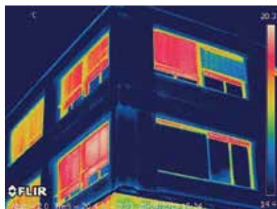
Abb. 8: Einsatz der Wärmebildkamera in der Bauthermografie.
